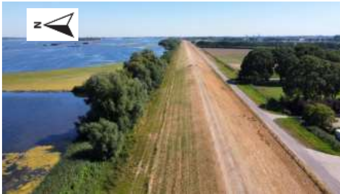
Figuur 7-8 De verdroging van een dijk afhankelijk van de expositie van het binnentalud (Eland, z.d.)
