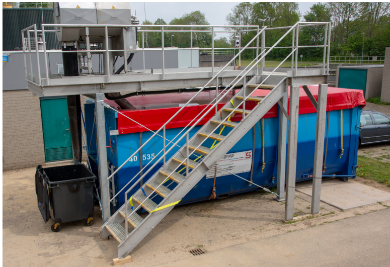
AFBEELDING 2.4 GROFVUILROOSTER EN BUFFERTANK
