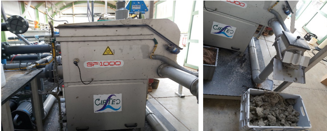
AFBEELDING 3.5 FIJNZEEF EN UITGERPERST ZEEFGOED
