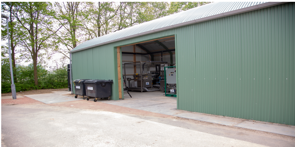
AFBEELDING 2.3 PROEFHAL WATERFABRIEK2.0 OP RWZI TERWOLDE (WATERSCHAP VALLEI EN VELUWE)
