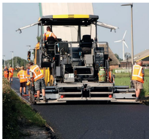
FIGUUR 20 AANLEG SMA MET ZEEFGOEDCELLULOSE ALS AFDRUIPTREMMER. LINKS DE TOEGANGSWEG VAN RWZI ST ANNAPAROCHE EN RECHTS DE FIETSSNELWEG (N357)
