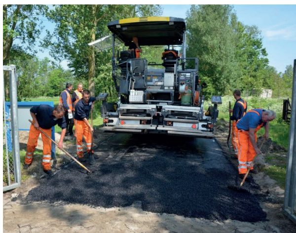
FIGUUR 20 AANLEG SMA MET ZEEFGOEDCELLULOSE ALS AFDRUIPTREMMER. LINKS DE TOEGANGSWEG VAN RWZI ST ANNAPAROCHE EN RECHTS DE FIETSSNELWEG (N357)
